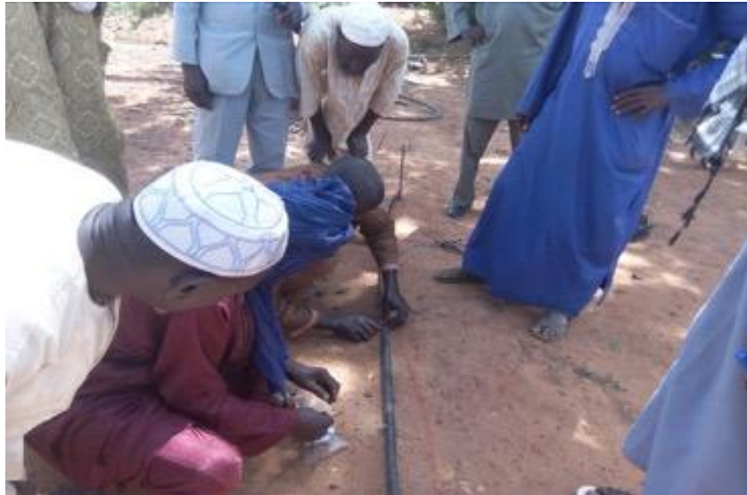
Image 15 : Raccordements des réducteurs qui relient le réseau principal au réseau secondaire
