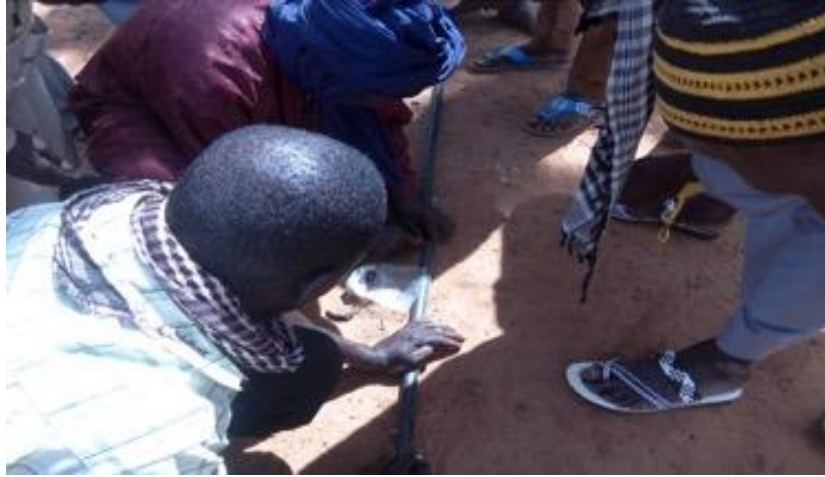
Image 14 : Perçage des lignes des goutteurs à l'intervalle de 50 cm entre le réseau secondaire
