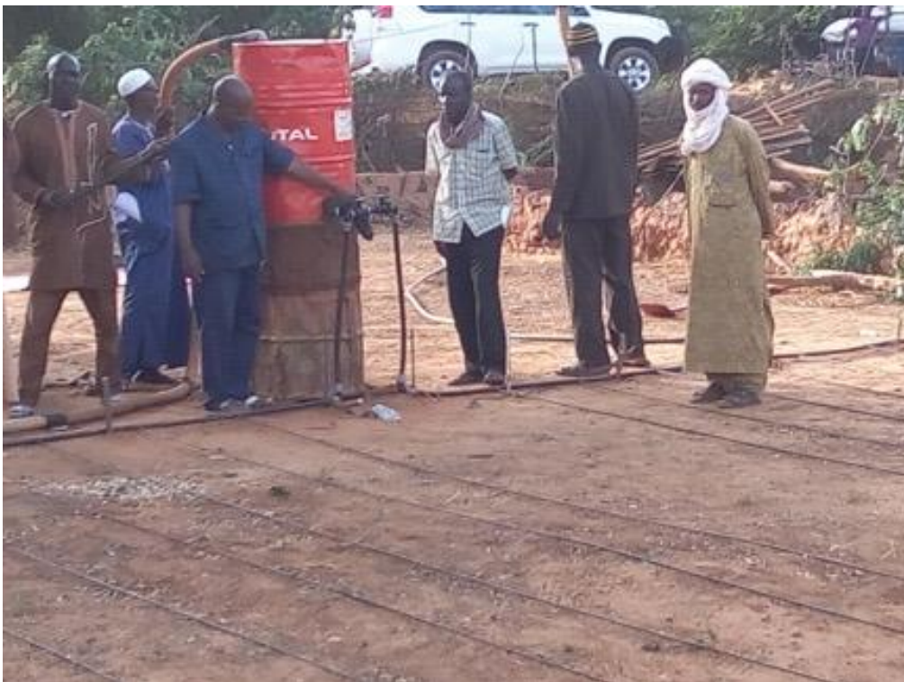
Image 21 :Etape finale de l'installation du réseau goutte à goutte
