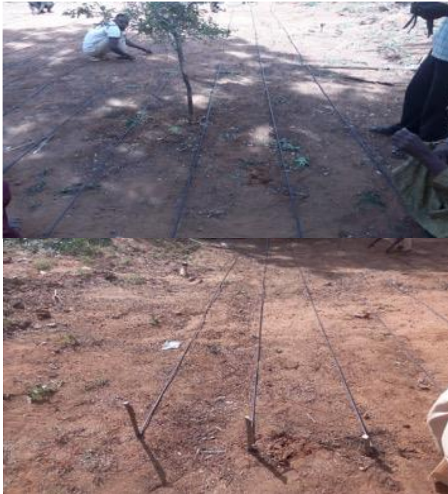
Image 17 :Fixation des lignes de goutteurs sur le réseau de 5,10 m avec des piquets en bois
