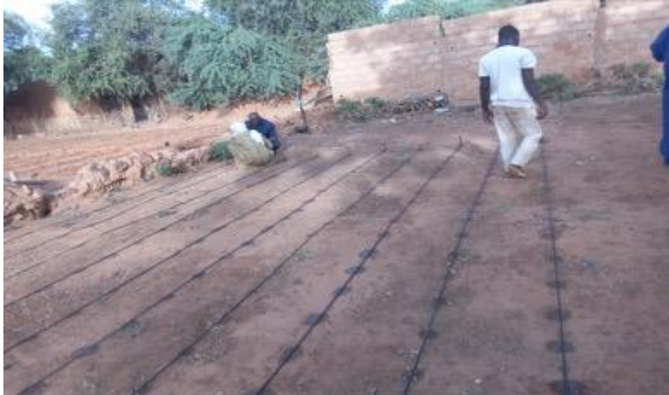
Image 22 : Essai du réseau goutte à goutte avec 100 litres d'eau.
