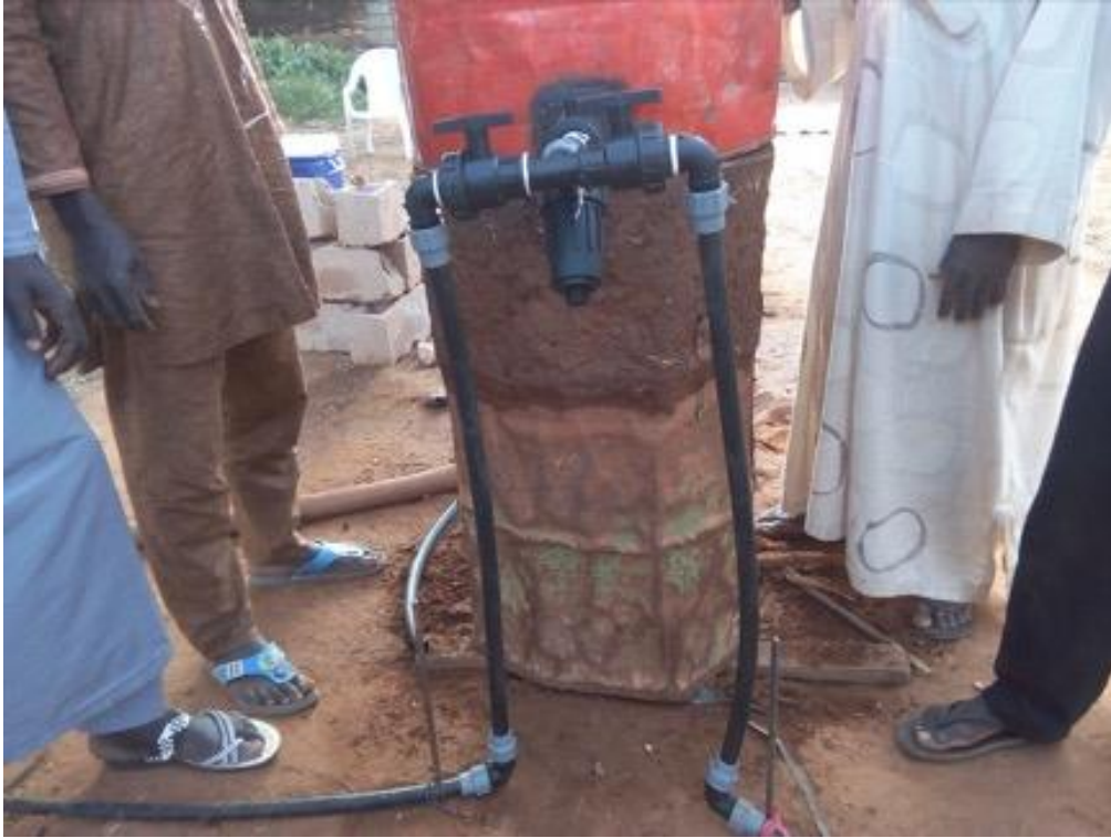
Image 20 :Raccordement des tuyaux de passage d'eau dans chaque réseau principal
